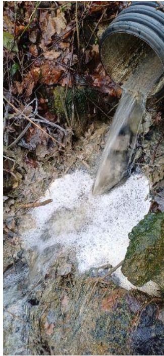
Buse enterrée depuis une cuve à lisier jusqu'au ruisseau de Charpagne Photo prise par le garde-pêche de la Fédération le 19 janvier 2024
